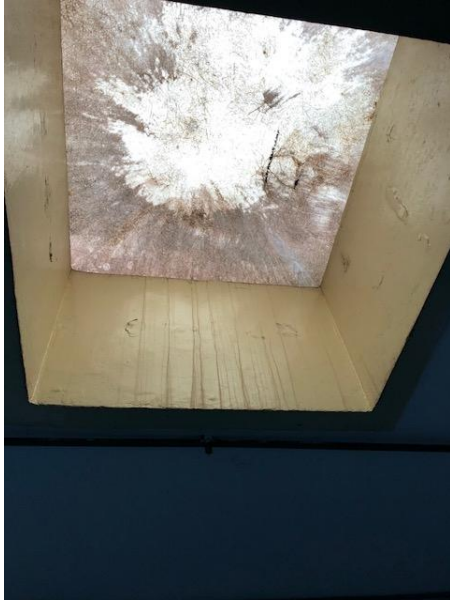
FOTO 8 – Domos existente a ser substituído
